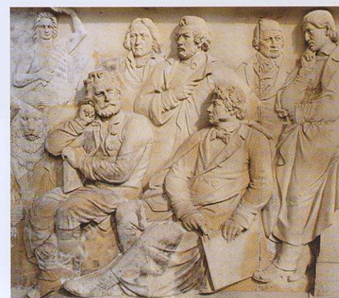
110 Der Relieffries an der Alten Nationalgalerie a Bräunliche Verfärbungen nach der Behandlung mit konzentrierten Ammoniumcarbonatlösungen b Eine mit Paste belegte Fläche in der Phase der Abtrocknung c Der Relieffries nach Abnahme der Paste
