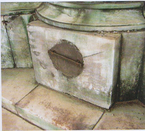
115 Das Reiterdenkmal des Großen Kurfürsten im Ehrenhof des Schlosses Charlottenburg in Berlin vor der Instandsetzung a Gesamtansicht b Detailansicht des Sockels
