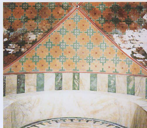
119 Durch Vergipsung gebildete Verfärbungen auf einer Wandmalerei in der Herz-Jesu-Kirche in Berlin a Vorzustand b Musterfläche nach einer Behandlung mit ammoniumcarbonathaltigen Pasten, Salzbehandlung und Restaurierung
