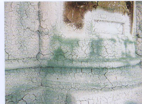
117 Der Sockel des Reiterdenkmals während der Behandlung mit einer Paste zur Entfernung der Kupferverbindungen, Phase der Abtrocknung
